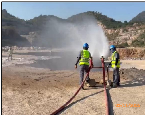
รูปที่ 2-44 ปืนฉีดน้ำแรงดันสูงฉีดกลุ่มฝุ่นละอองขณะทำ การระเบิด
